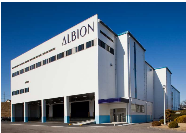
▲ 東日本流通センター<新物流棟>
