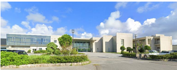
沖縄健康バイオテクノロジー研究開発センター
